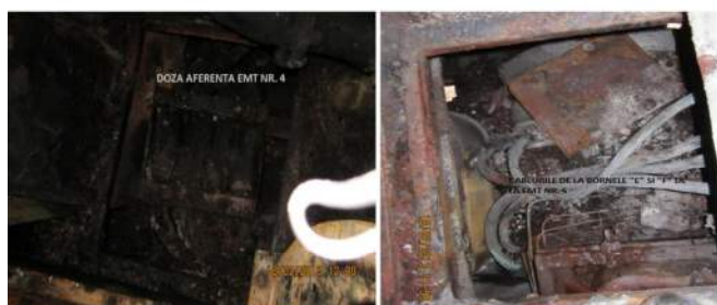
Fig.3 Cablurile de forță de la EMT 4 și EMT 5
